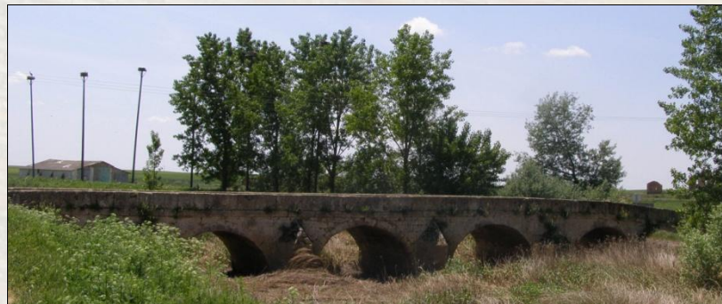
Foto 4. Puente del Mercado
